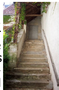
Escalier du pauvre
